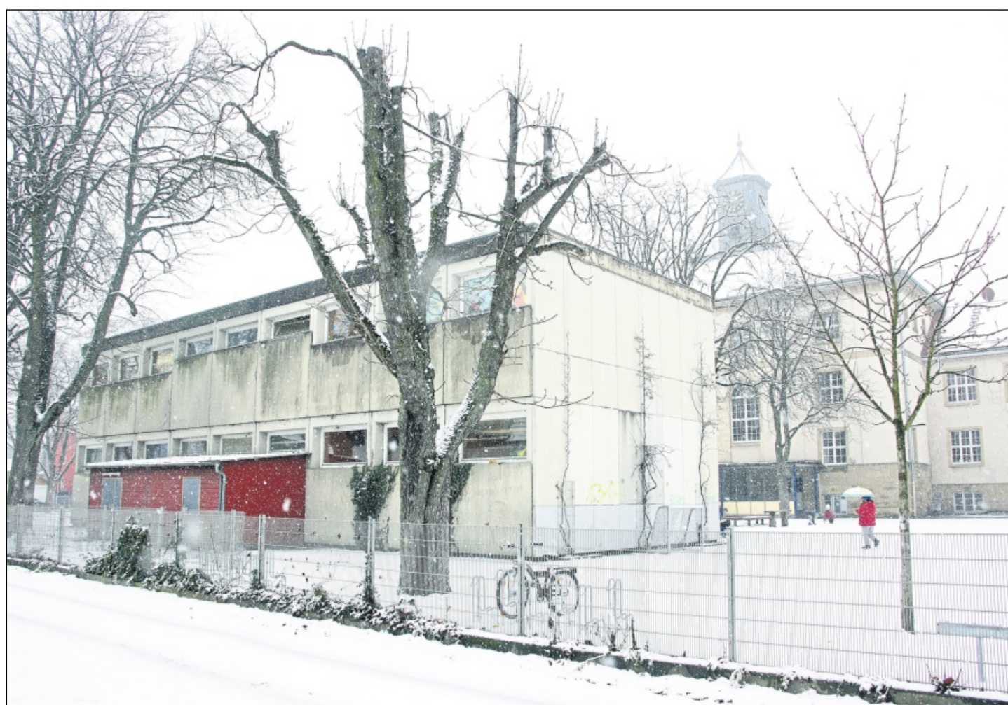
ZU WENIG PLATZ für Grundschule und Hort ist ab September an der Viktor-von-Scheffel-Schule in Knielingen. Ob der Hort aus den Pavillons im Schulhof in Container hinter der Reinhold-Crocoll-Halle umzieht, ist nun doch noch offen. Foto: jodo
